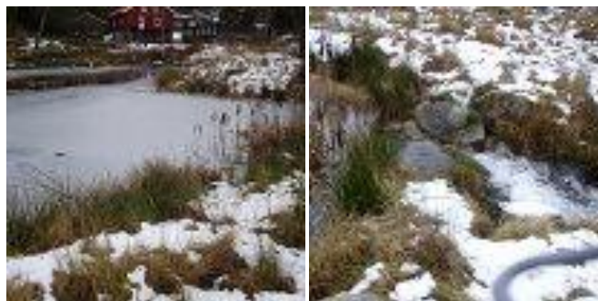
Nya dammbyggnaden nedanför Torpa kvarn
